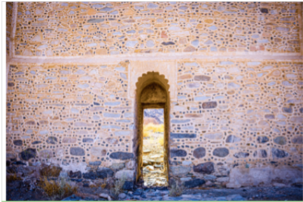
التعليق على الصورة: عين زبيدة: إحدى فتحات تصريف المياه في قنطرة الخاصرة التي تحمل قناة عين زبيدة
