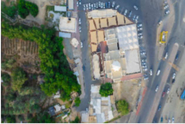
التعليق على الصورة: صورة جوية لمسجد الجعراة وتظهر المرافق المحيطة به وبئر الجعراة
